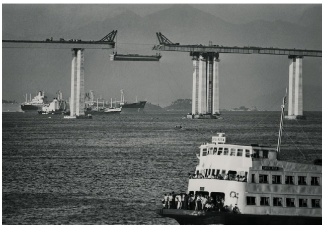
Figura 1 - Ponte Rio-Niterói em construção
